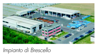
Impianto di Brescello
